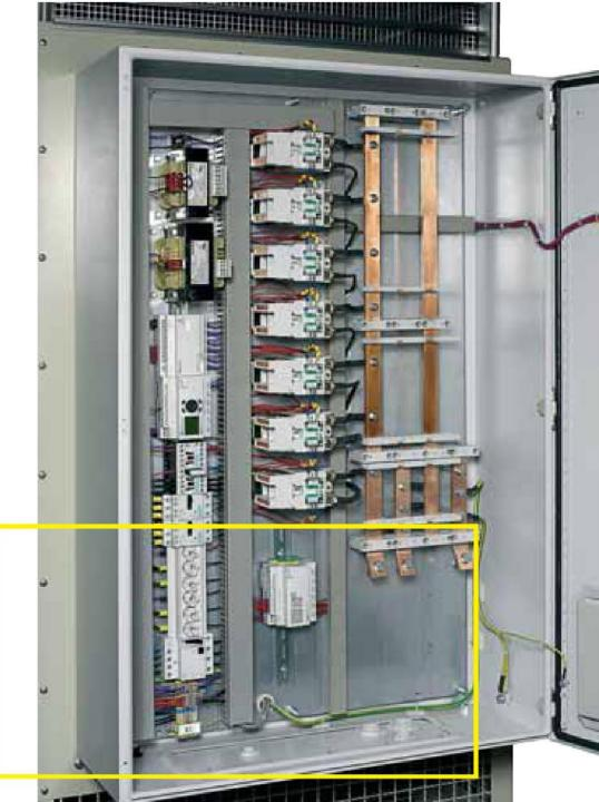
В качестве опции предлагается распределительное устройство в комплекте с предохранителями, контакторами, элементами обслуживания и контроля.
