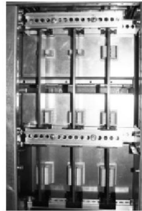
Применение соединителей прямоугольных электрических серии СП в выдвижной ячейке
