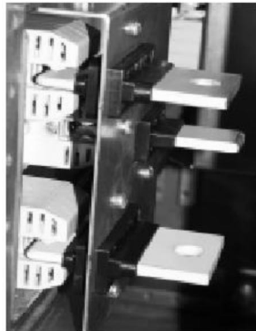
Применение шиндержателей наборных серий ШН, ШНП, изоляторов опорных полимерных серии ПИО в ГРЩ
