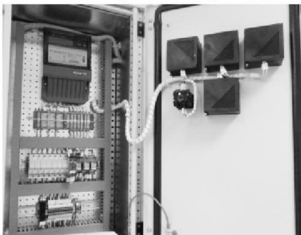
Применение шиндержателей наборных серий ШН, ШНП, изоляторов опорных полимерных серии ПИО в ГРЩ
